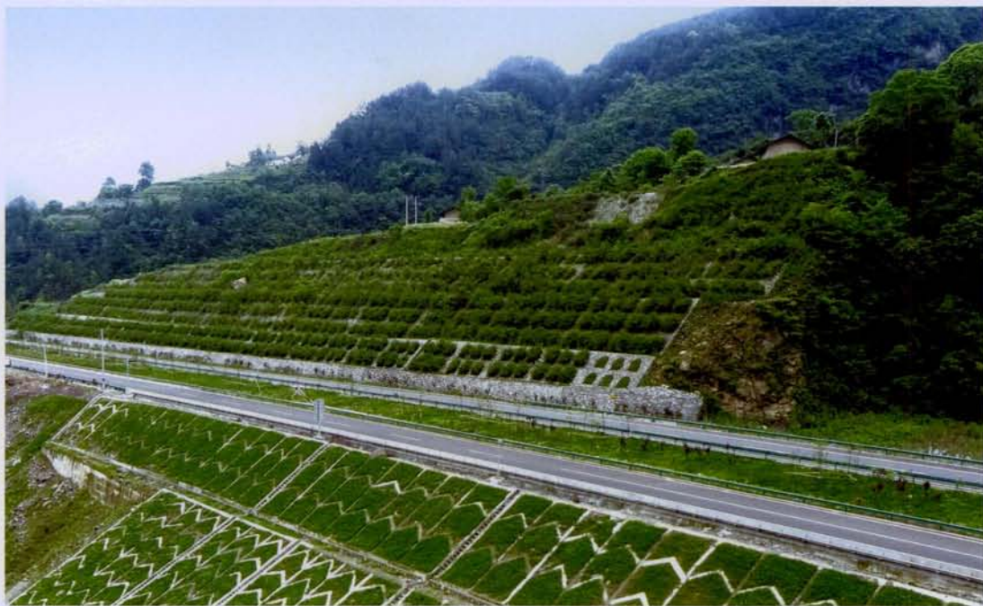
湖北宜巴高速公路边坡防护及绿化工程
