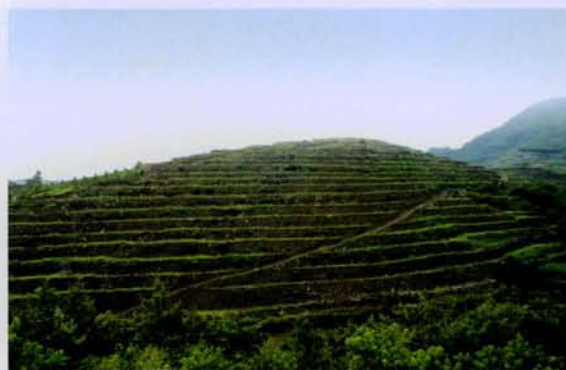
湖北省丹江口市黑沟河小流域坡面治理工程
