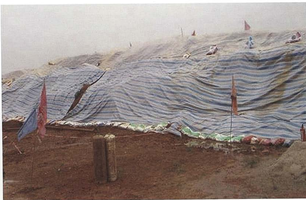
中缅原油天然气管道工程临时堆土防护
