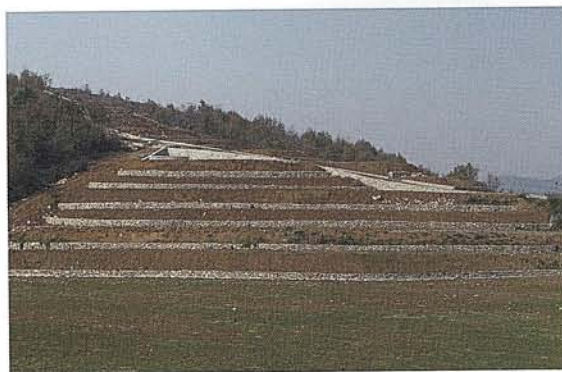
湖北省丹江口市坡面治理工程
