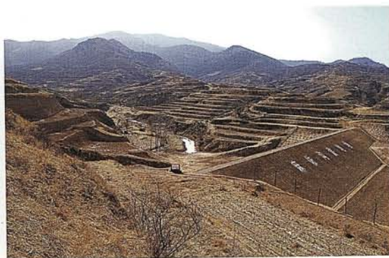
山西省古交市水土流失综合治理
