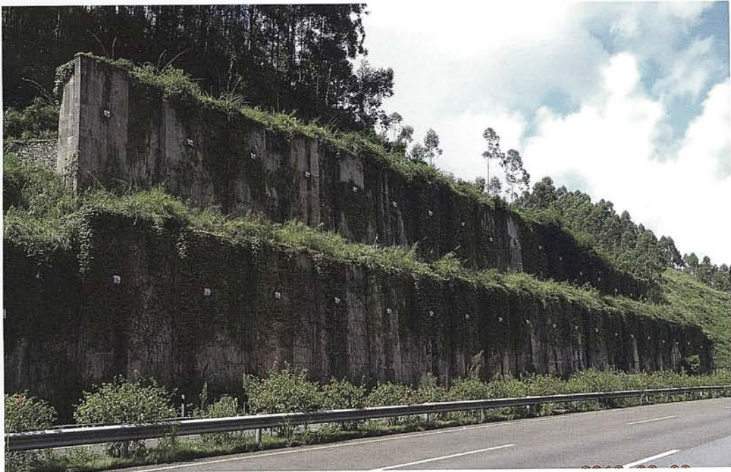
广东广明高速公路西樵至更楼段边坡水土保持防护工程
