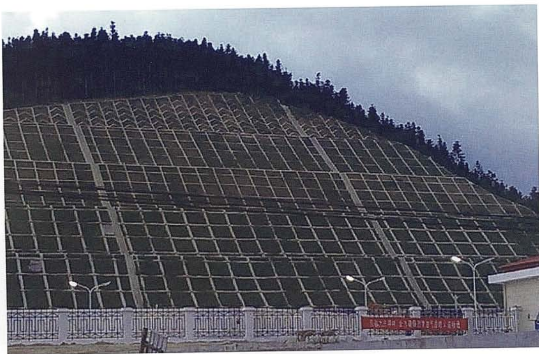
中缅原油管道龙陵站边坡防护及绿化
