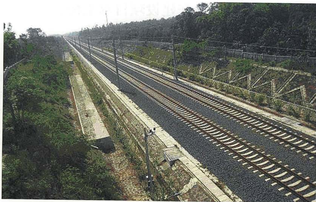
海南东环铁路水土保持综合防护
