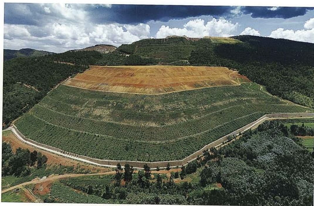
云南安宁磷矿1号矿山排土场水土保持综合防护
