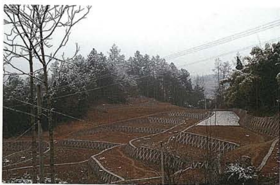
四川省北川县水土流失综合治理
