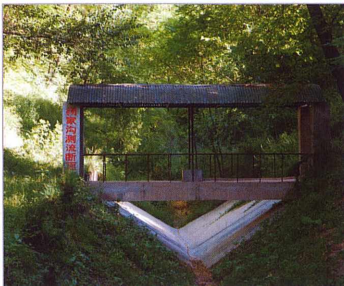
甘肃省庆阳市西峰区杨家沟控制站
