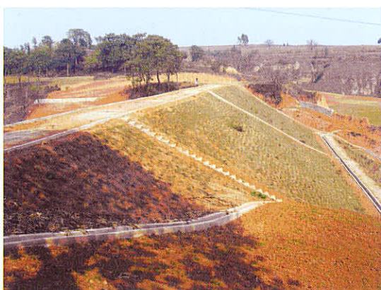
河南省嵩县腾王沟坝系大黄箭沟骨干坝
