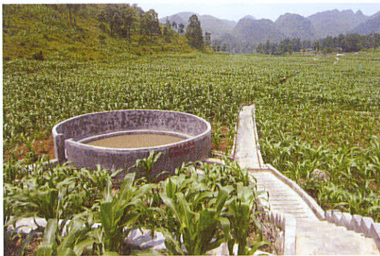
云南省晴隆耕作道路集雨结合蓄水池
