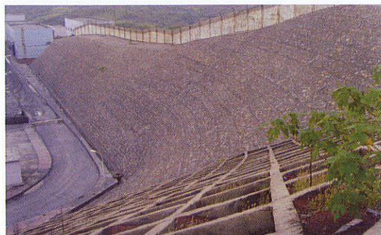
湖南水口山铅烟气工程浆砌石护坡
