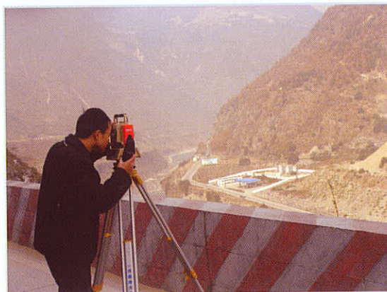
四川南广高速现场测量
