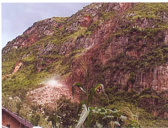
岩体崩塌威胁农户和庄稼
