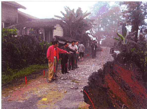
■ 滑坡造成平掌乡道路被毁
