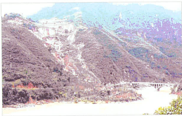
■ 特大滑坡造成保康至襄樊干线交通中断
