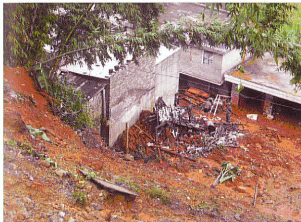
■ 新平县泥石流涌进房舍
