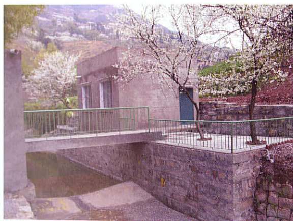
■ 重庆市万州区油房沟小流域控制站
