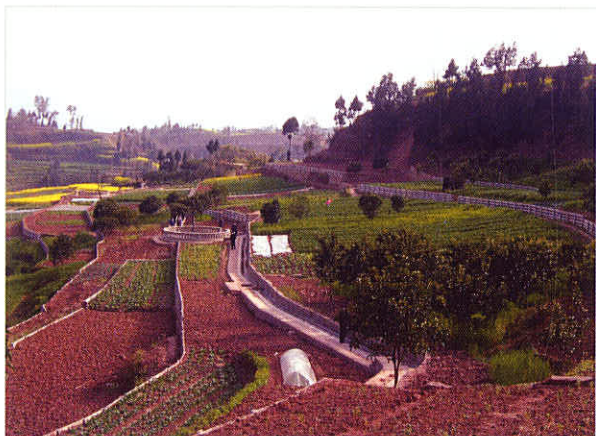
■ 四川省达县坡改梯及田间配套工程
