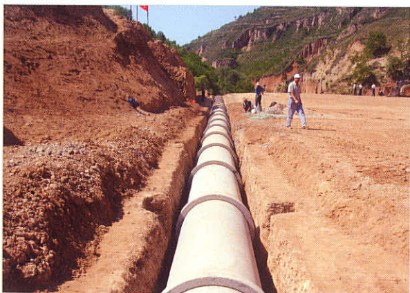
■ 正在施工的甘肃省正宁县骨干坝卧管
