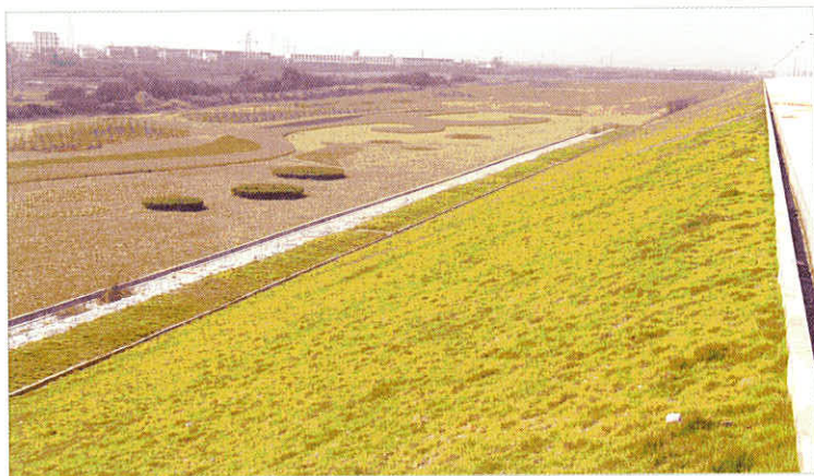
■ 大房郢水库工程护坡及绿化措施
