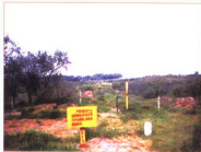
输气管线恢复治理
