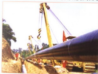
西气东输重点工程湖北段忠武输气管道工程
