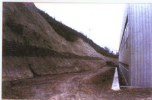
京煤集团技改项目水土保持工程
