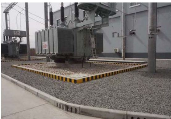
枣林变电所碎石压盖和排水系统
