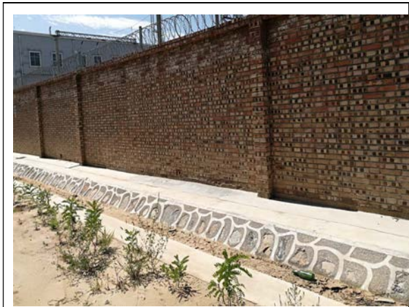
东河南变电所周边截水沟和灌木
