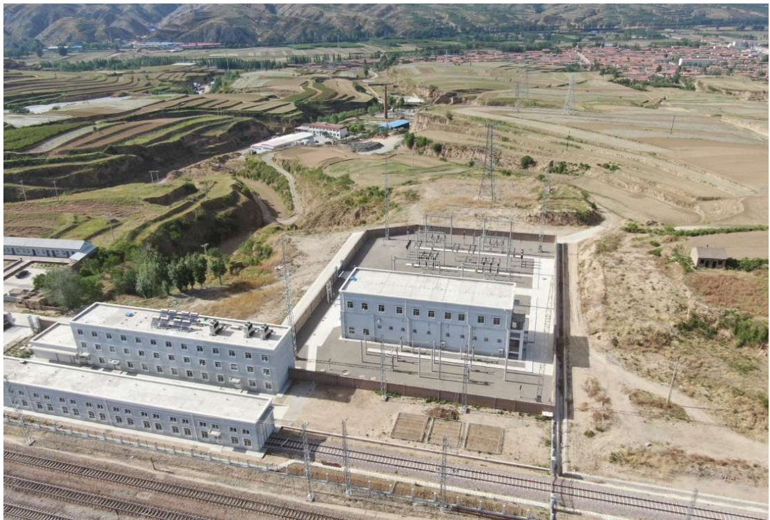
东河南站改造情况
