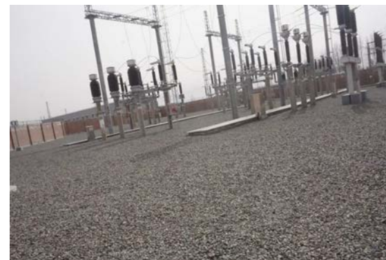
东河南变电所碎石压盖
