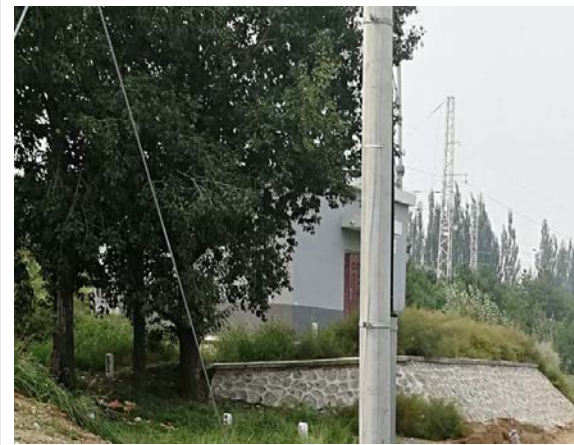
华岩站绿化和边坡防护
