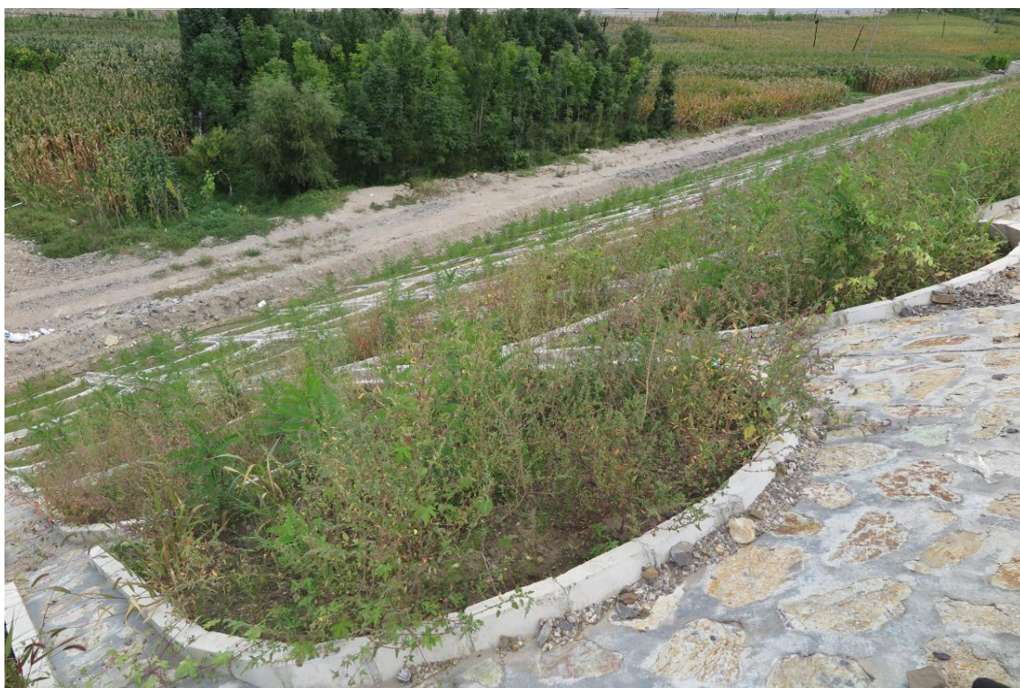
路基边坡拱形骨架护坡
