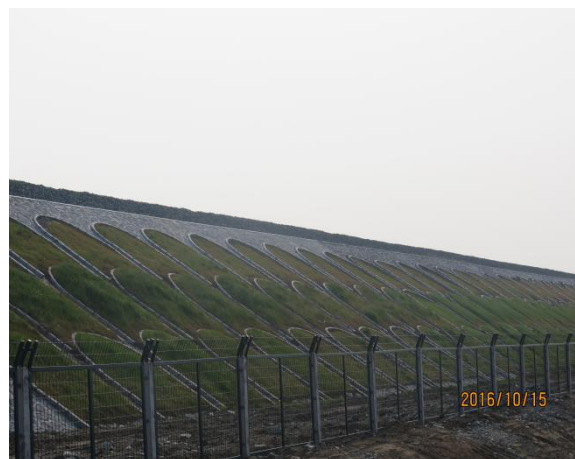
浆砌石骨架护坡填方路基监测点
