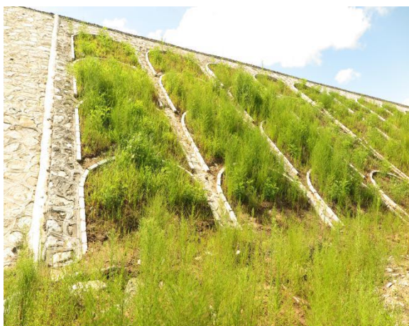
浆砌石骨架护坡填方路基监测点
