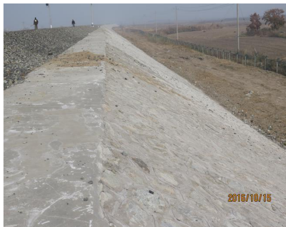
浆砌石边坡填方路基监测点
