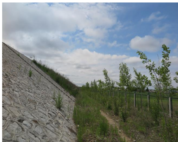
浆砌石边坡填方路基监测点
