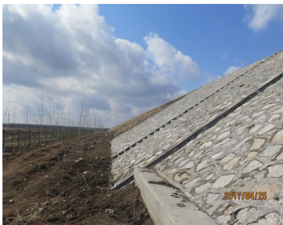
浆砌石边坡填方路基监测点
