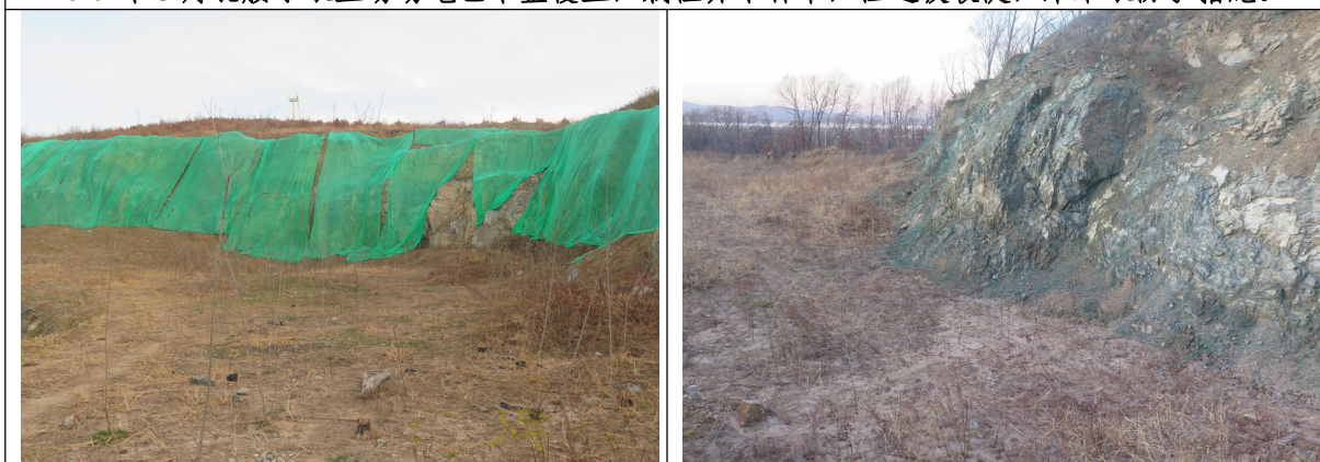
2019 年 6 月驼腰子取土场，边坡较陡区域采取挂网，并种植攀爬植物进行防护。
