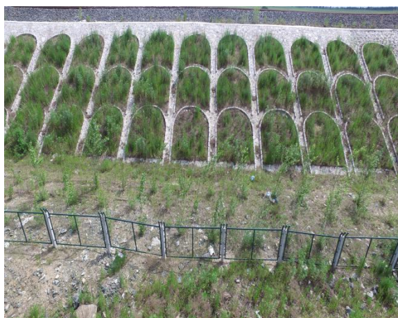
浆砌石骨架护坡填方路基监测点
