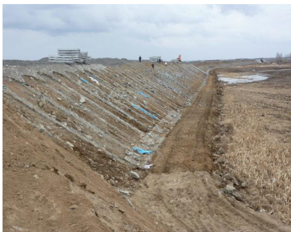
浆砌石骨架护坡填方路基监测点
