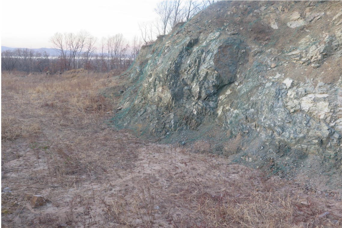
取土场边坡挂铁丝网防护
