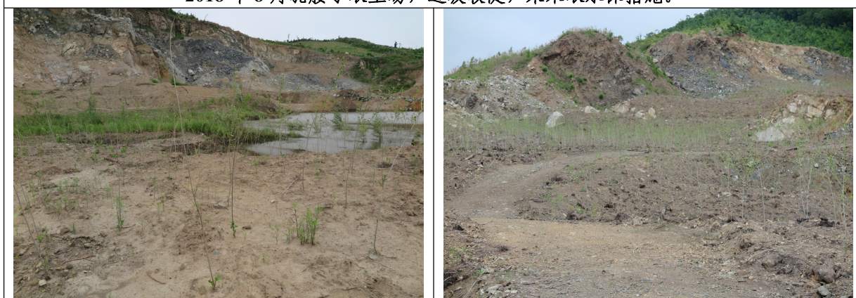
2019 年 5 月驼腰子取土场场地已平整覆土，栽植乔木种草，但边坡较陡，未采取防护措施。
