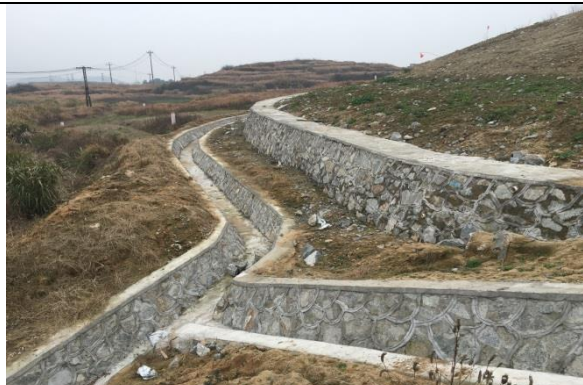
石佛岭隧道出口弃渣场（2016 年 4 月）
