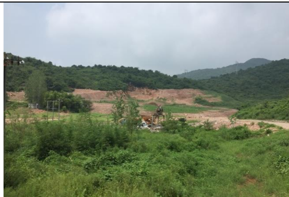
郭家湾隧道出口弃渣场（2017 年 9 月）
