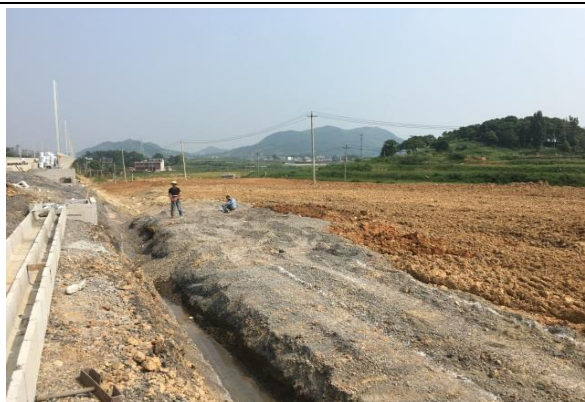
施工临时用地平整覆土（2015 年 12 月）
