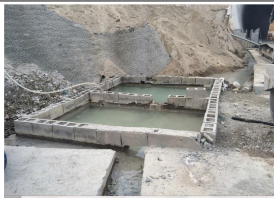
施工临时沉砂池和排水沟（2015年12月）
