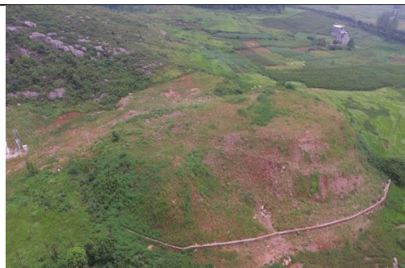
蔡青隧道弃渣场（2017 年 9 月）
