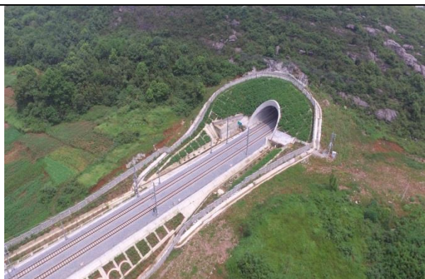
蔡青隧道出口(2017 年 9 月)
