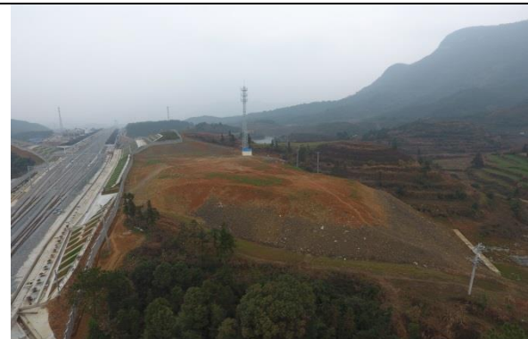
枫林站弃渣场（2017 年 1 月）
