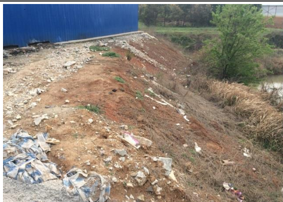
施工场地边坡临时植草绿化（2015年12月）
