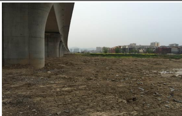
施工场地平整（未绿化 2015 年 12 月）
