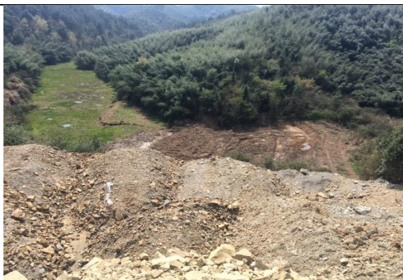
野鸭池弃渣场（2016 年 1 月）
