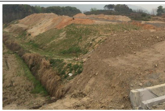
弃渣场施工期临时绿化（2016年6月）
