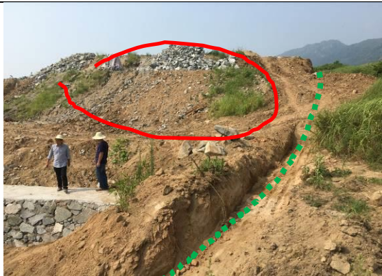
石佛岭隧道出口弃土场（2016 年 3 月）
