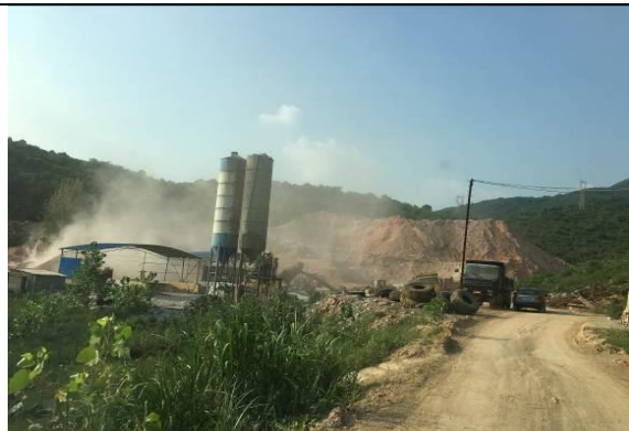
郭家湾隧洞入口渣场（2016 年 7 月）
