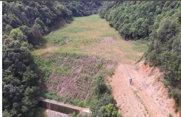
毛坪灶弃渣场（2017 年 6 月）
