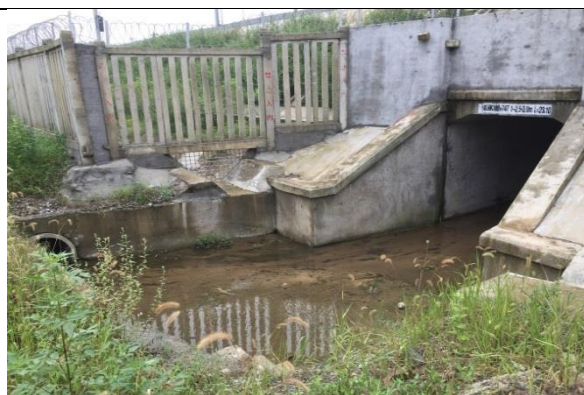
路基沉砂池(2017 年 9 月)
