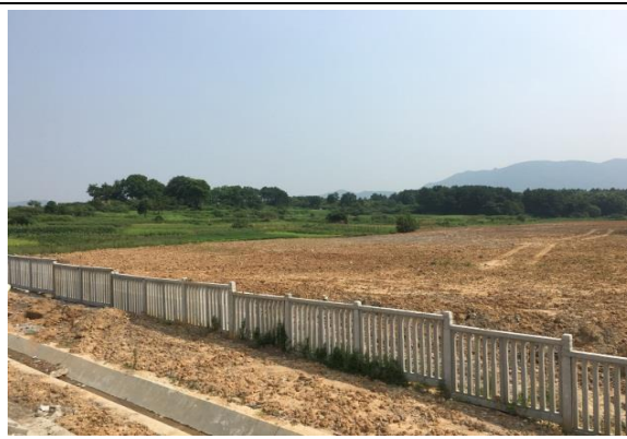
施工临时用地平整覆土（2015 年 12 月）
