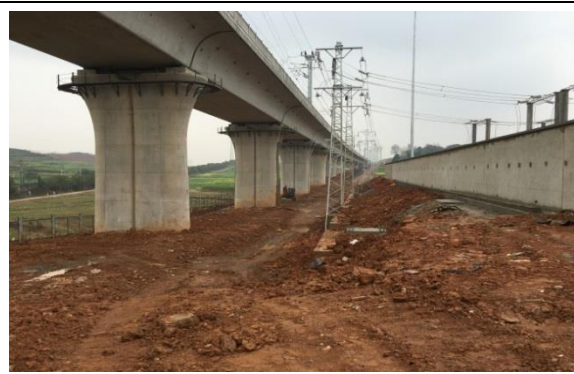
桥梁下侧平整绿化（2015 年 12 月）
