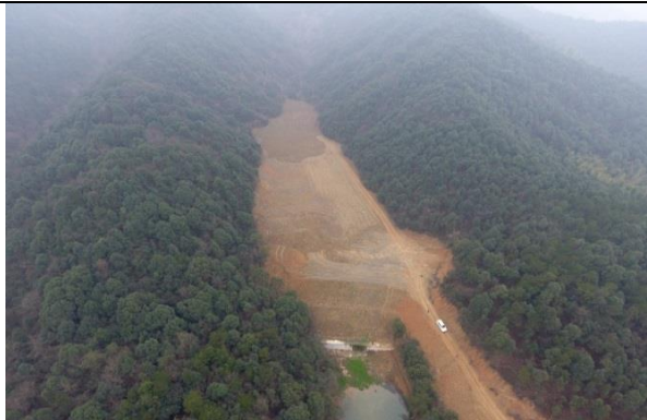
茅坪皂弃渣场（2016 年 12 月）
