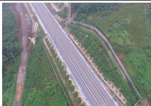
路基边坡防护(2017 年 9 月)
