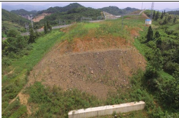
枫林站弃渣场（2017 年 9 月）
