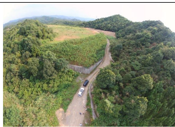
野鸭池弃渣场（2017 年 9 月）
