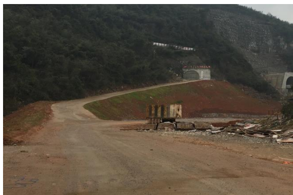
施工便道边坡及施工场地（2016年9月）
