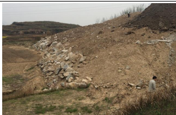
临时堆土边坡堆石渣临时拦挡（2016年3月）
