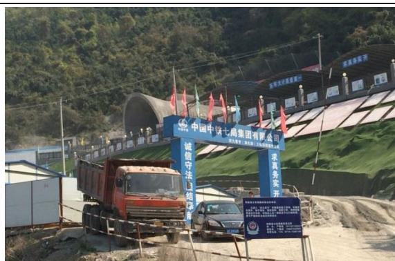
隧道施工边坡临时覆盖（2016年6月）
