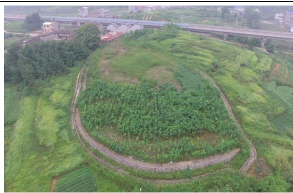
石佛岭隧道出口弃渣场(2017 年 9 月)
