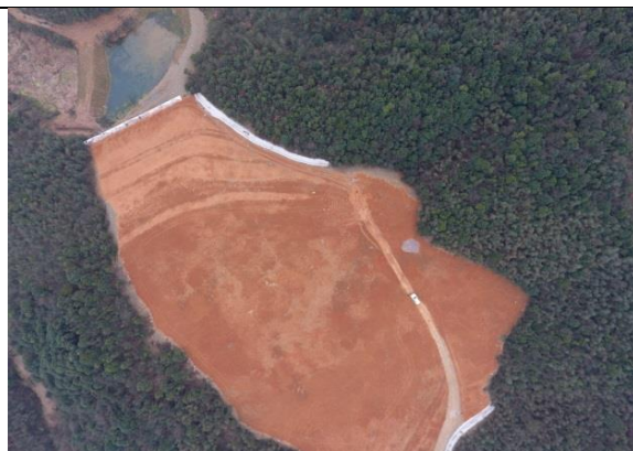
野鸭池弃渣场（2016 年 9 月）
