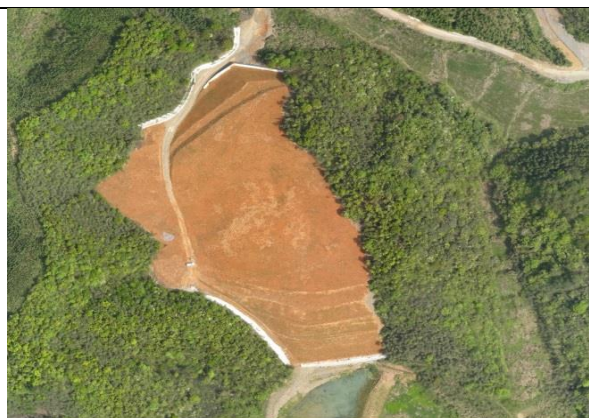
野鸭池弃渣场（2016 年 12 月）
