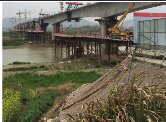
桥梁施工临时拦挡（2016年6月）
