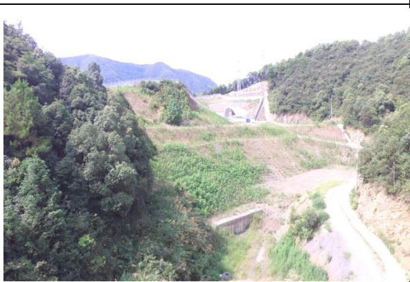
李家庄隧道出口弃渣场（2017 年 9 月）
