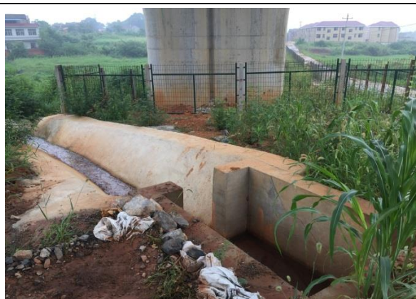
路基排水沟(2017 年 9 月)
