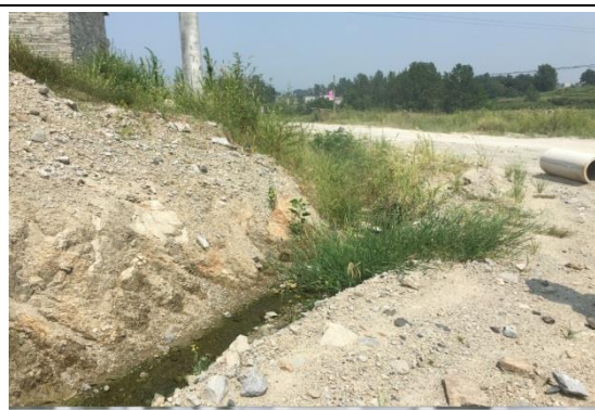
取土场临时排水沟（2016年6月）
