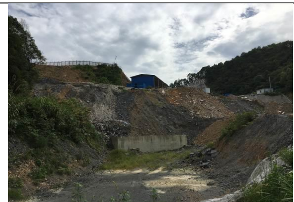
李家庄隧道出口弃土场（2016 年 7 月）
