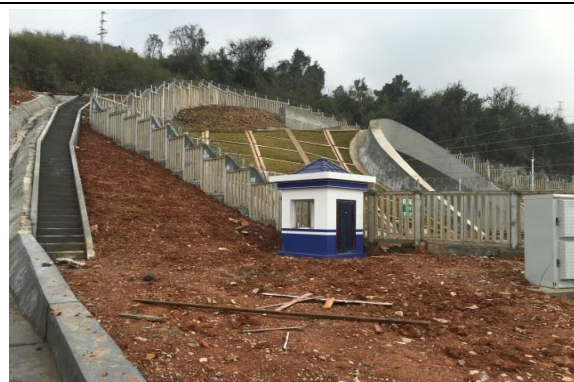
隧洞洞口防护及绿化（2016 年 9 月）
