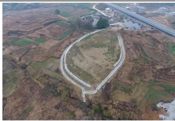
石佛岭隧道出口弃渣场（2017 年 1 月）
