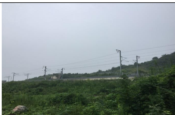
路基防护（绿化）(2017 年 9 月)
