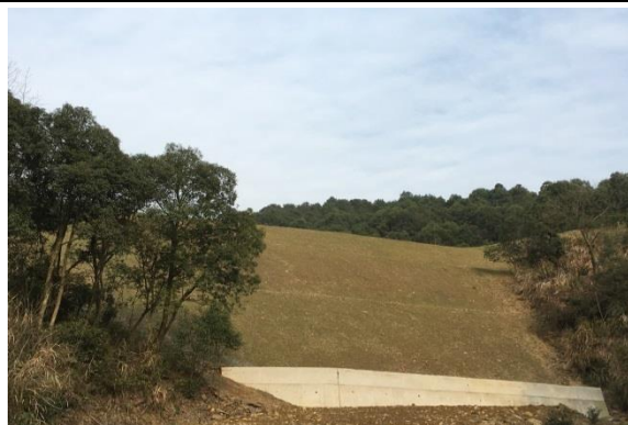
弃渣场防护覆土整地（2017年6月）
