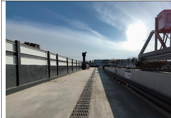
8标 施工生产生活区-排水沟2023.12
