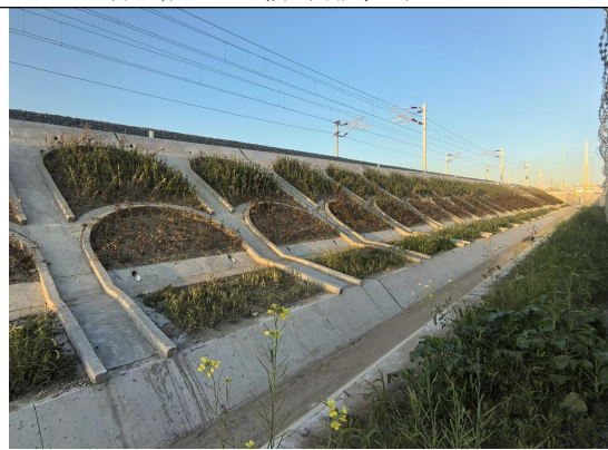
8标 路基区-拱形骨架护坡2025.3
