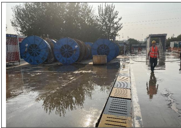
8标 隧道区-洒水降尘2023.9
