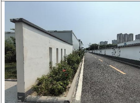
8标 施工生产生活区-临时绿化2024.7
