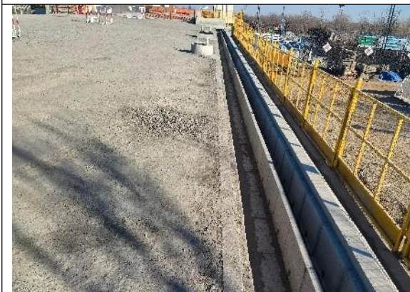
8标 路基区-路基排水2024.12
