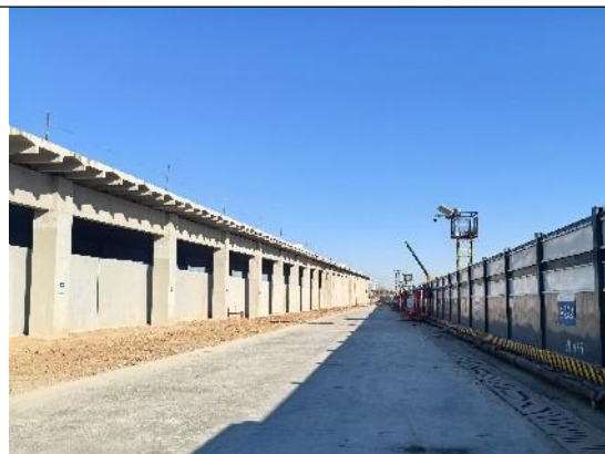
8标 路基区-临时排水沟2024.12
