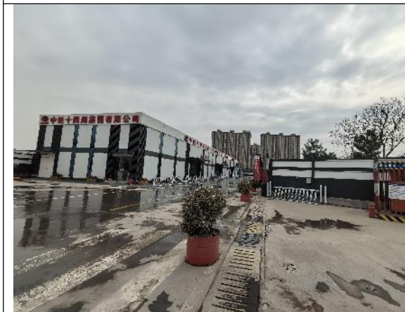
8标 施工生产生活区-临时排水沟2024.3
