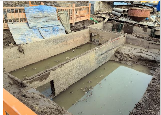
8标 桥梁区-泥浆池2023.12
