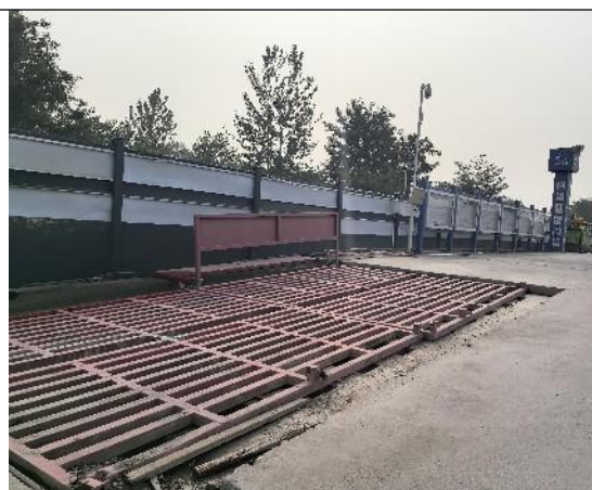
8标 路基区-洗车沉淀池2024.9
