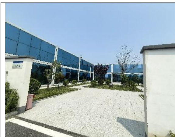
8标 施工生产生活区-临时绿化2024.9
