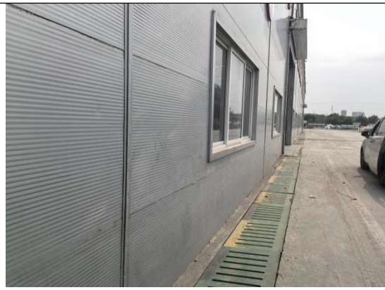
8标 施工生产生活区-临时排水2025.5
