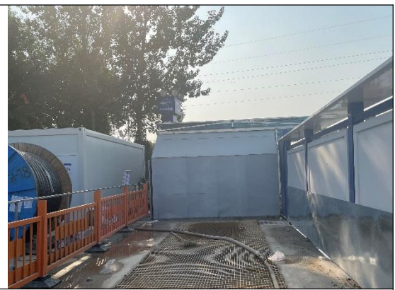
8标 隧道区-明挖段洗车沉淀池2023.9
