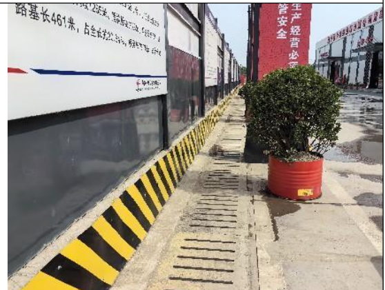
8标 施工生产生活区-临时排水沟2024.7
