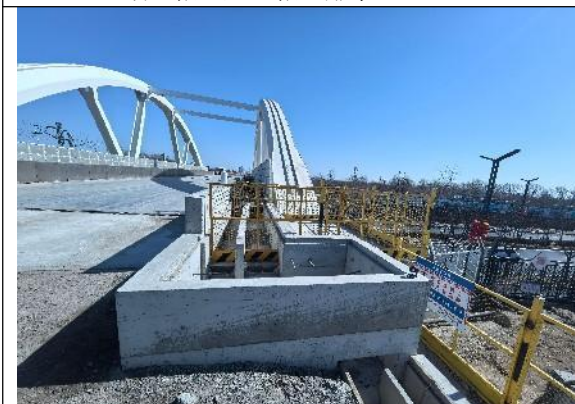
8标 桥梁区-桥梁排水2025.3
