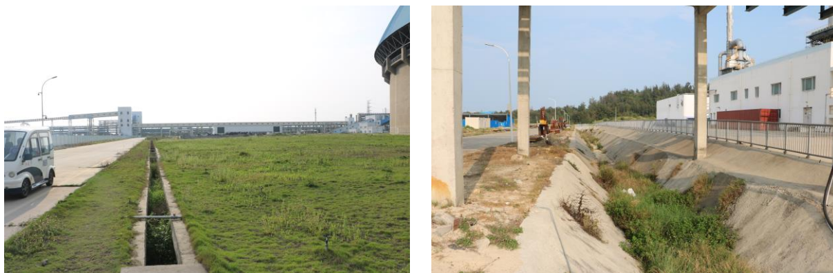
配套及辅助设施区海水直流冷却系统排洪沟区
