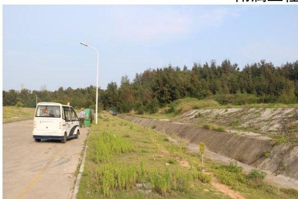
附属工程区排洪沟
