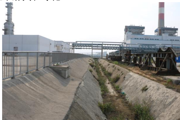
配套及辅助设施区临时防护和排洪沟
