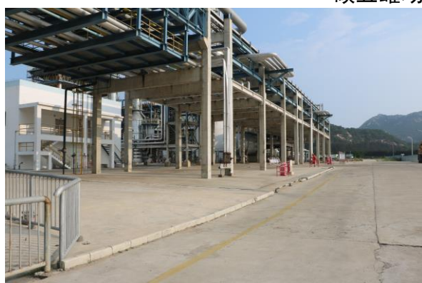
主厂区盖板排水沟和场地硬化
