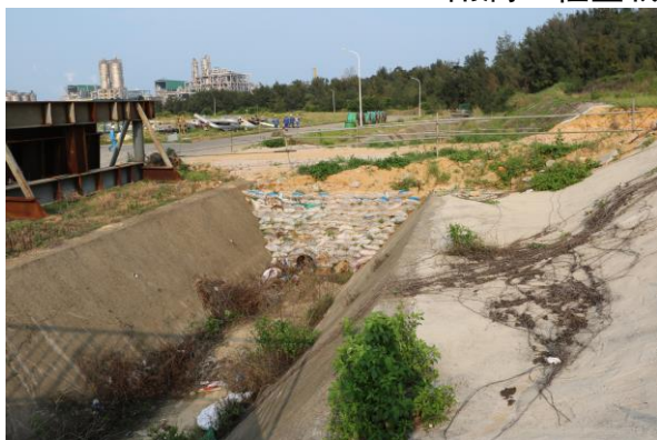
配套及辅助设施区临时防护和排洪沟
