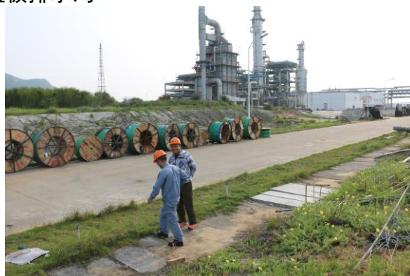
附属工程区盖板水沟
