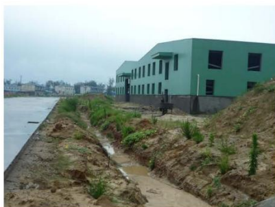
施工期临时排水沟与施工结束后浆砌石排水沟
