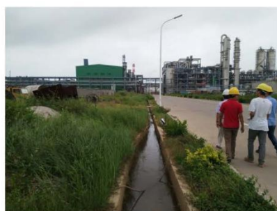
施工期临时排水沟与施工结束后浆砌石排水沟
