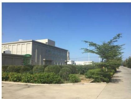
综合楼周边景观绿化现状
