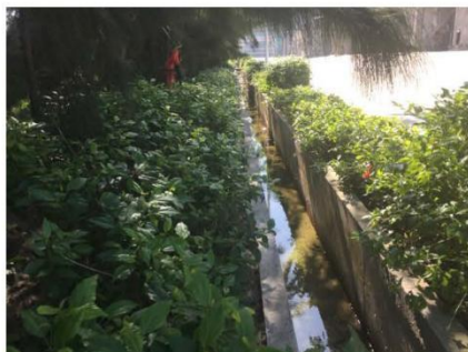
道路两侧景观绿化与排水沟
