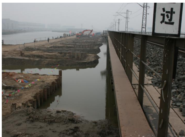
湖林河大桥人工剥离表土和临时拦挡
