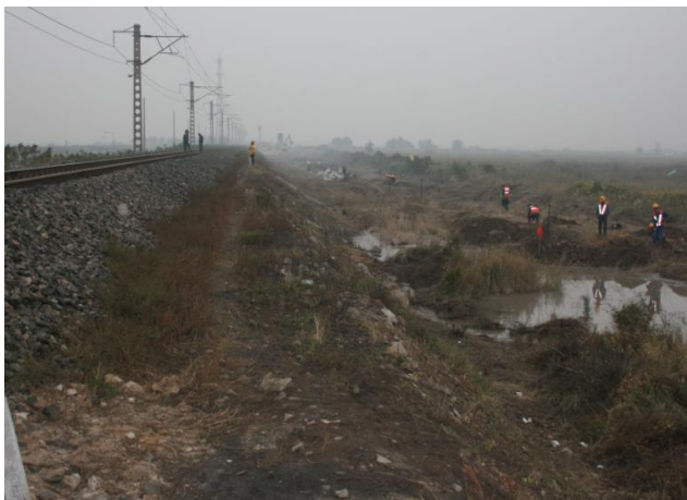
湖林河大桥人工剥离表土和临时拦挡
